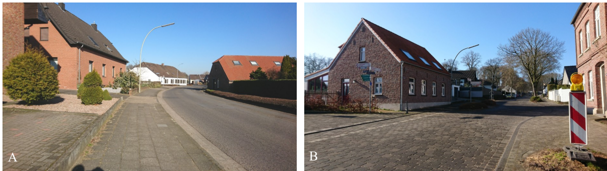
Abbildung 12: A) Abschnitt der Straße Niederend mit geschotterten und gepflasterten Vorgärten B) Aldekerker Straße mit punktuell gepflanzten Straßenbäumen
