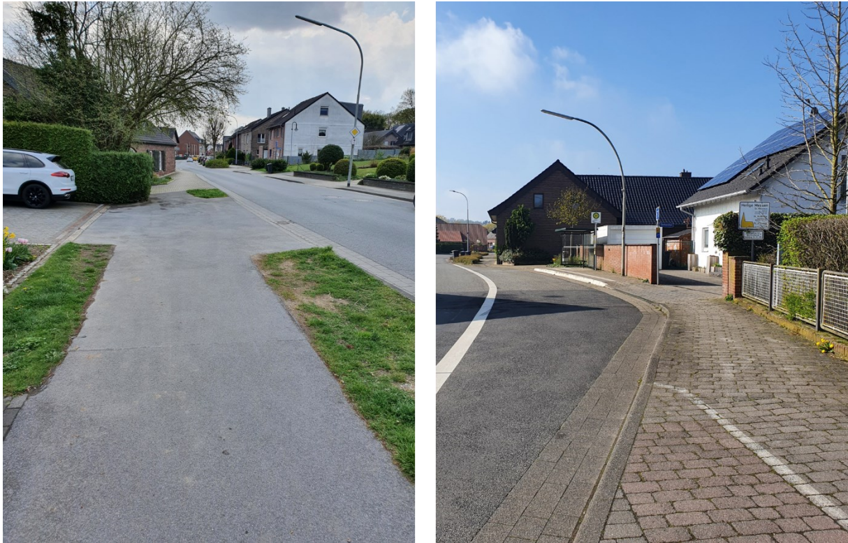
Abbildung 26: Fehlende Einfädelungshilfen für den Radverkehr [eigene Aufnahmen]
