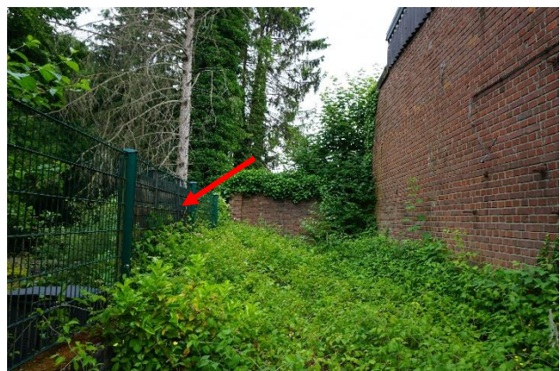
Abb. 29: Horchbox, Waldseite, nördliche Fassade
