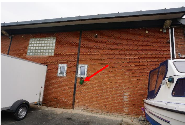
Abb. 28: Horchbox, südliche Fassade Hofseite
