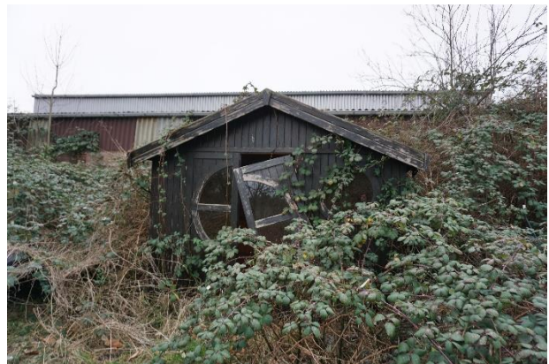
Abb. 24: verwilderter Gartenbereich im westlichen Teil mit Brombeerbewuchs und Schuppen (ISR 2023).
