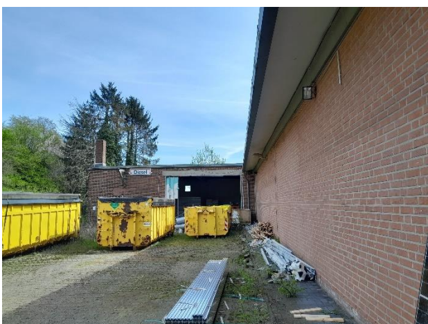
Abb. 5: Nordseite des Baumarkts mit angrenzender Lagerhalle und Hof (ISR 2023)
