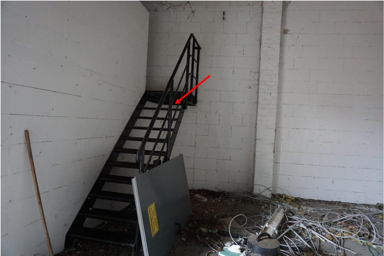
Abb. 30: Horchbox in der Lagerhalle
