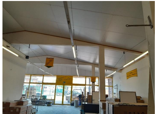
Abb. 4: Innenbereich des ehemaligen Baumarkts (ISR 2023).
