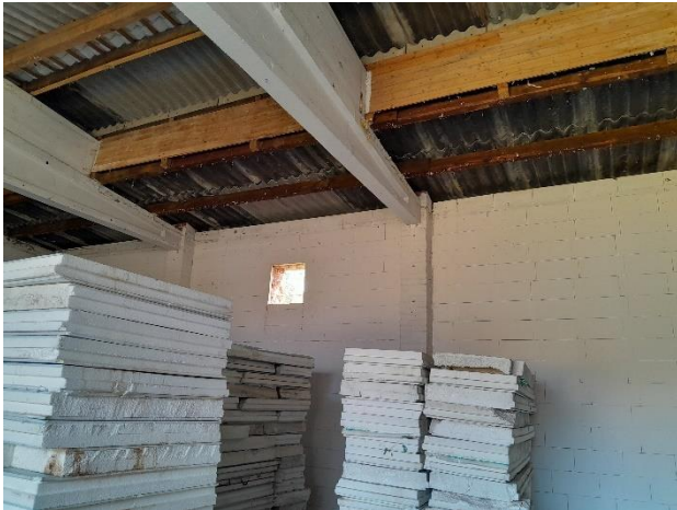
Abb. 7: Innenbereich der Lagerhalle (ISR 2023).
