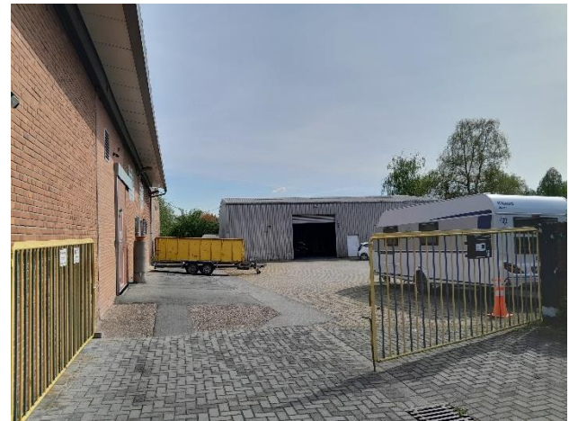
Abb. 10: südliche Fassade des Baumarkts, Blick auf Leichtbauhalle (ISR 2023).
