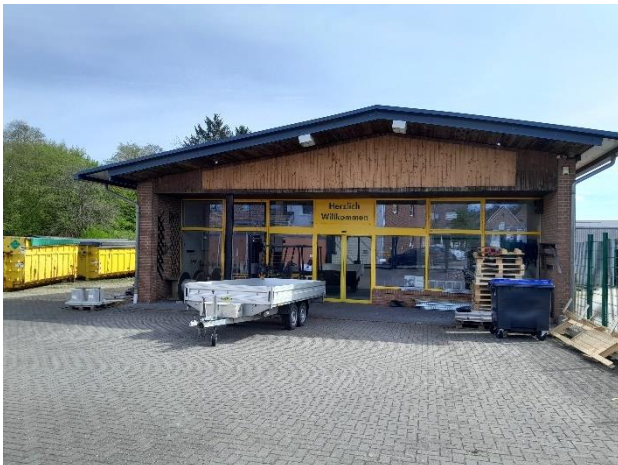
Abb. 3: ehemaliger Baumarkt, Frontseite (ISR 2023).
